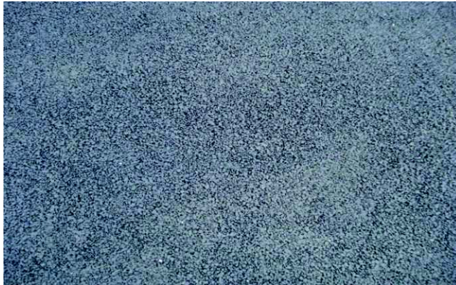
FIGURA 06 - Camada Porosa de Atrito Fonte: Autor
