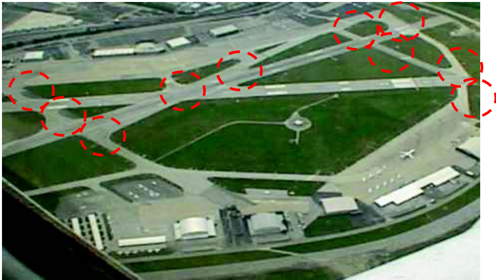
FIGURA 7 – Aeródromo com excessivos e confusos pontos de entrada na pista principal.
