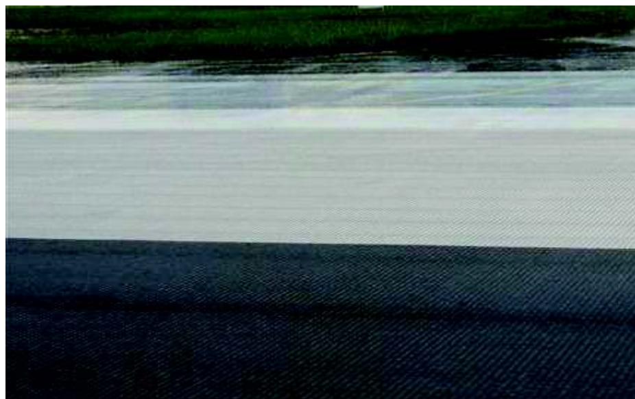
FIGURA 05 - Ranhuras transversais (grooving) Fonte: Autor
