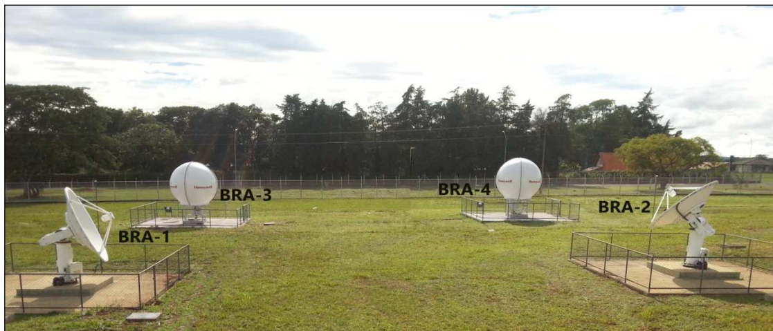
FIGURA 11 – Estação protótipo de quatro canais de rastreamento de satélites MEOSAR. Fonte: BRMCC (2013).
