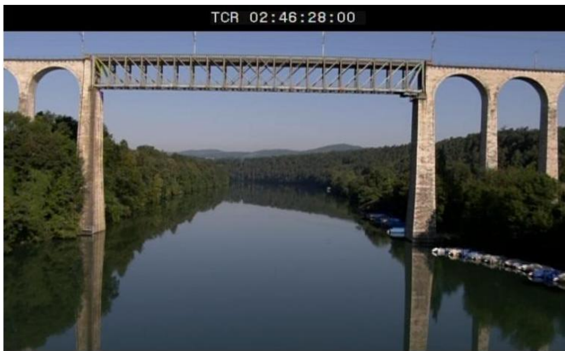
FIGURA 6: Ponte sobre o rio Rhine (BFU, 2009).
