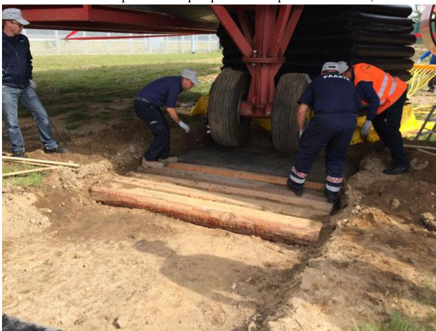
Figura 12 - Procedimento para retirar aeronave em situação Debocking
